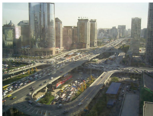
Figura 30: Red de carreteras en Beijing, China. Fuente: Manfred Breithaupt, 2006
