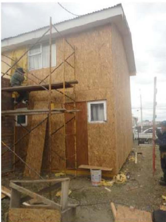
Inspección in situ de la ejecución de las faenas de Reacondicionamiento, controlando la colocación y protección de los materiales aislantes térmicos
